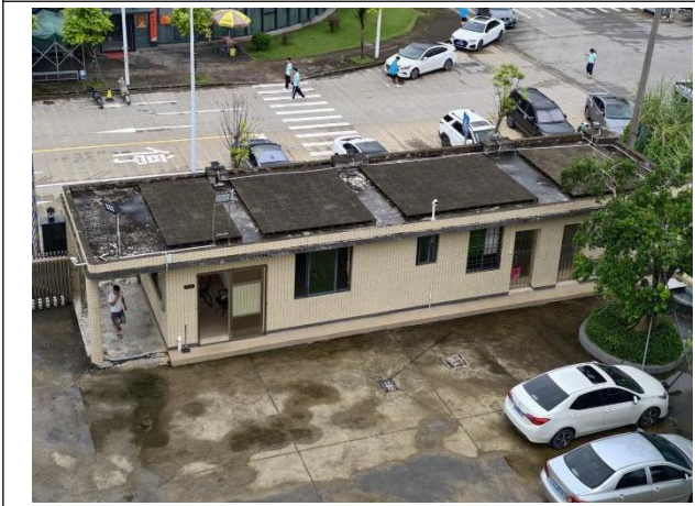
项目厂区内门卫室
