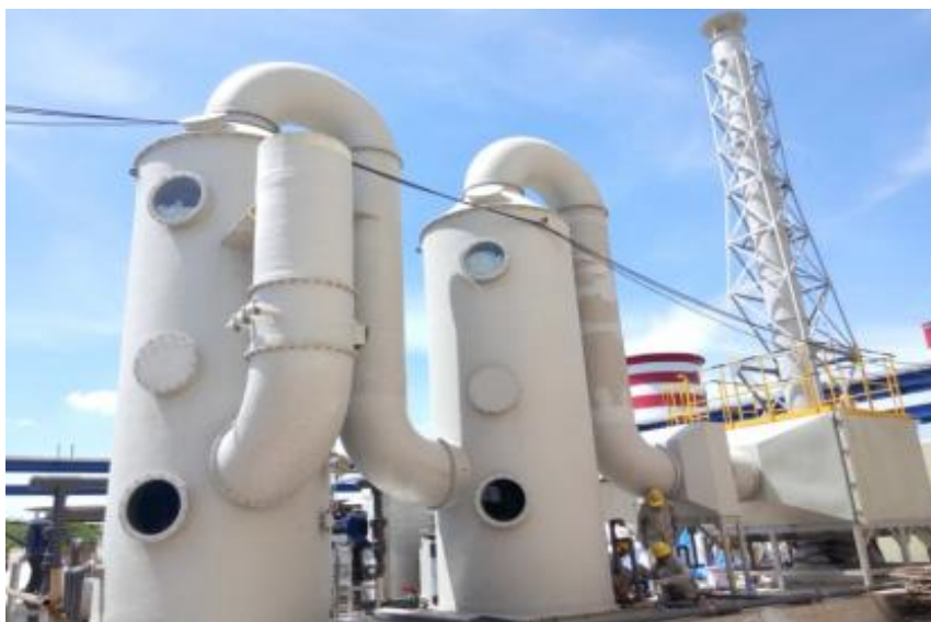
图4.3-4 二级化学洗涤塔示意图
