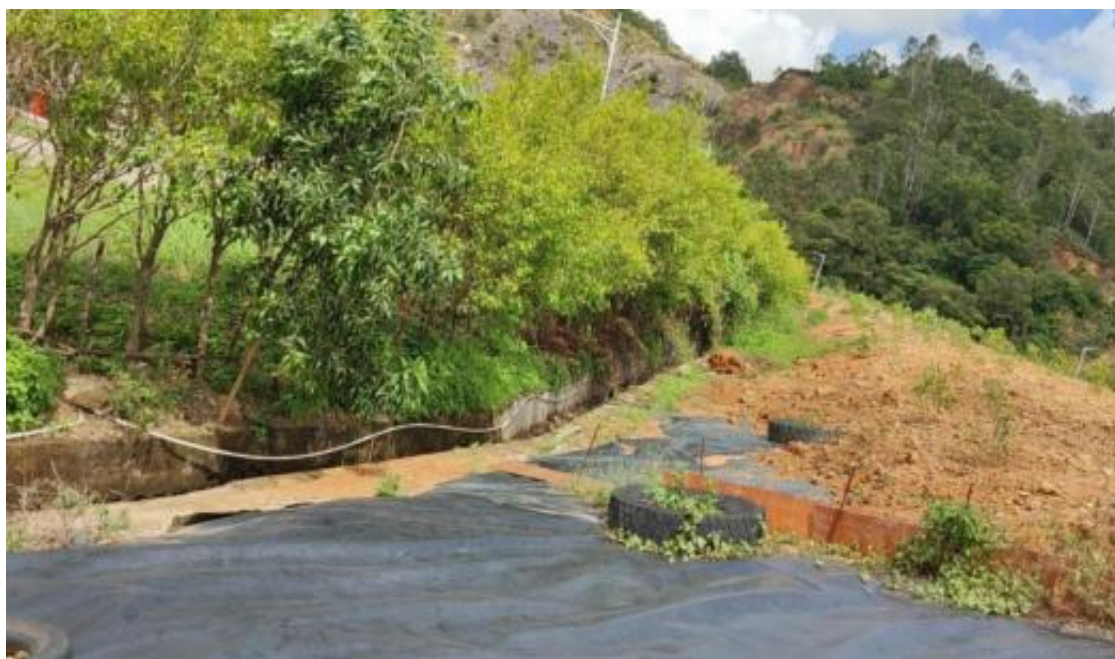
图3.1-15 大伯坑垃圾填埋场排水沟现状照片
