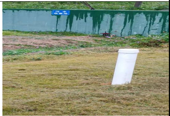
填埋区渗滤液收集池（靠废水站）
