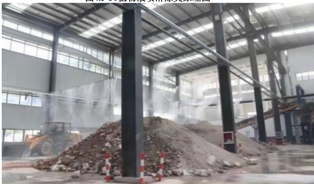
图4.3-32 除臭剂喷洒现场效果图
