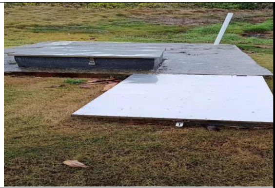
填埋区渗滤液收集池
