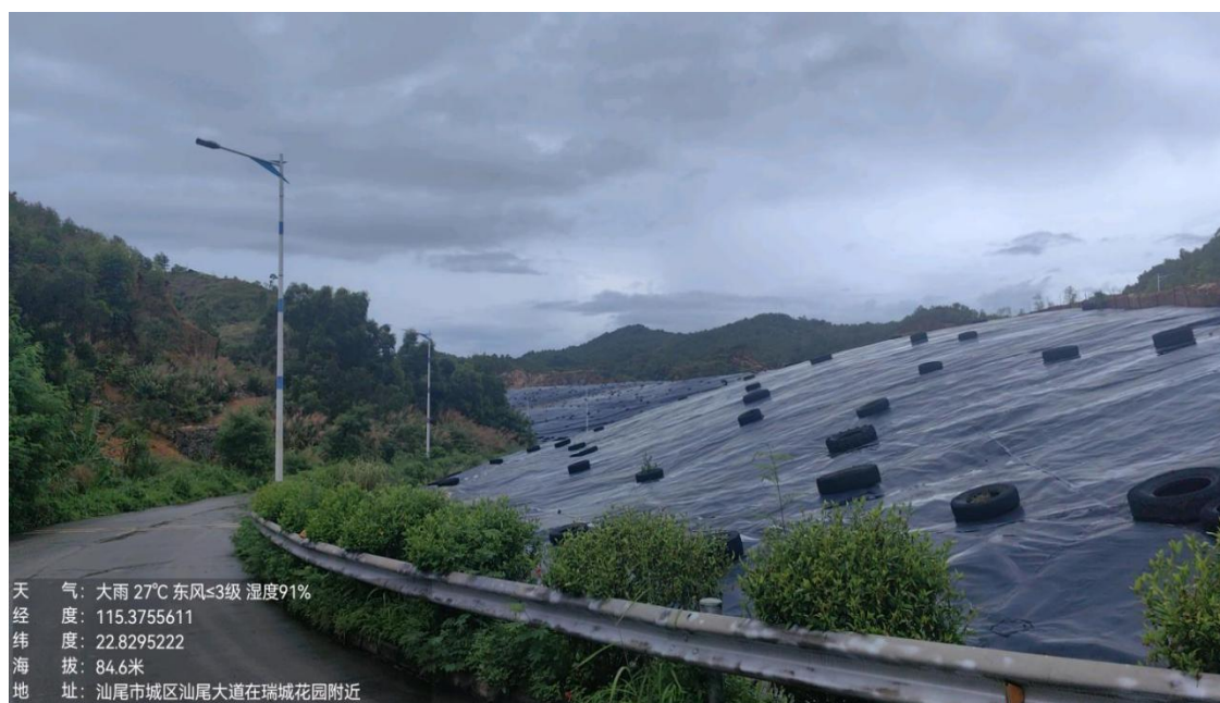
图3.1-14 HDPE防渗膜现场实拍图
