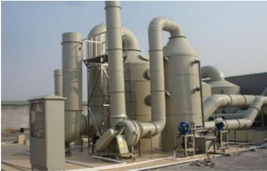
图7.2-1洗涤塔设备示意图
