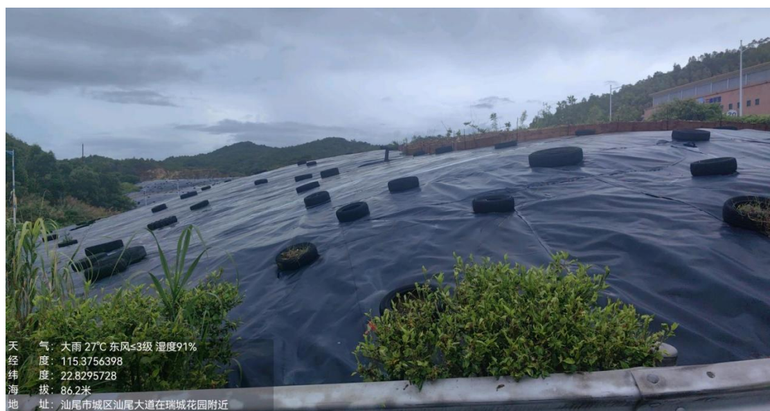
图 3.1-10 填埋气导排竖井实物图
