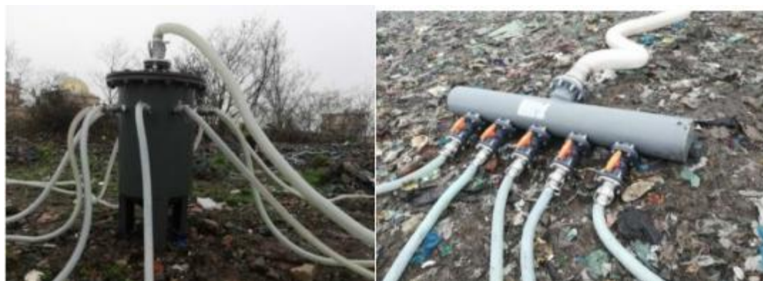
图4.3-2均布器连接示意图
