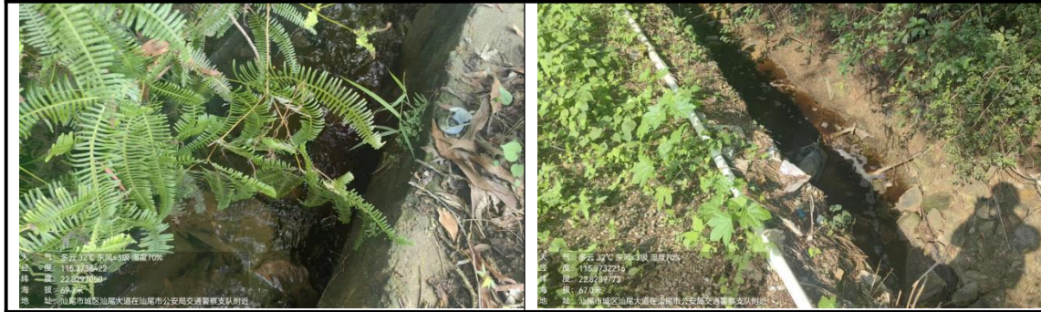
图3.1-5排水出口与公路东侧排洪渠现状
