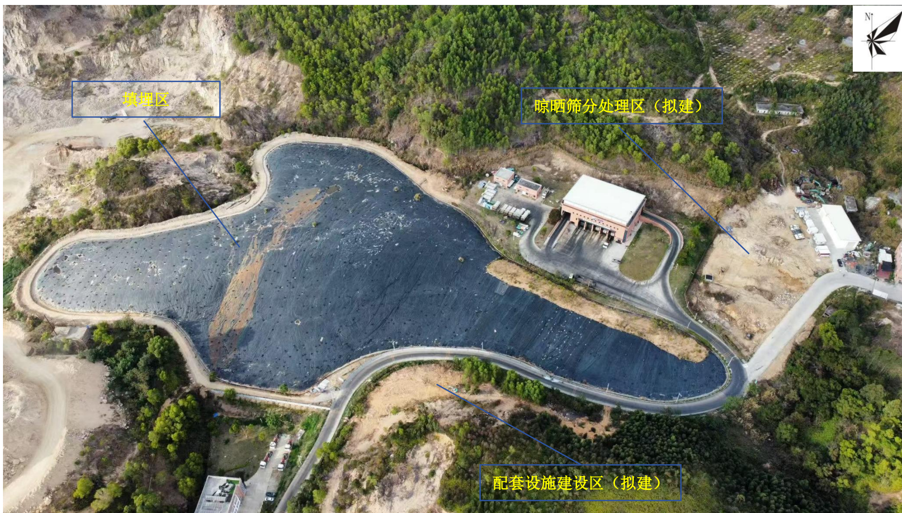
图 1.1-5 项目航拍照片
