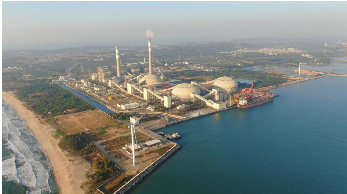
图 5.1.2-1b 汕尾电厂厂区俯瞰图
