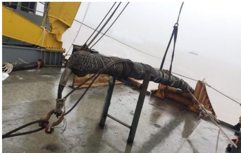
图 1.4.3-4 海缆连接牵引钢丝绳
