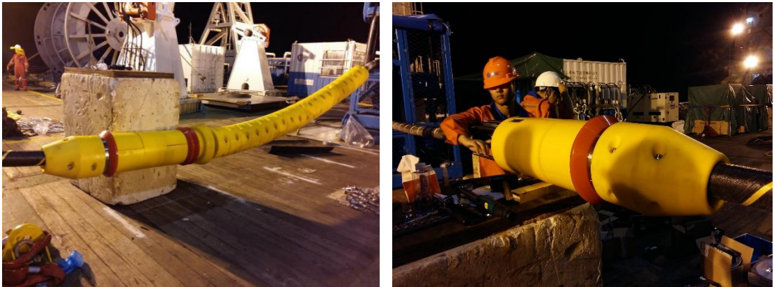
图 1.4.3-5 中心夹具和弯曲限制器安装
