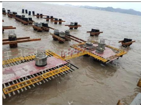
②桩帽底模安装
