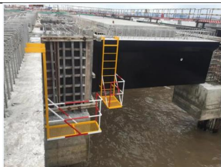
⑤纵横梁安装
