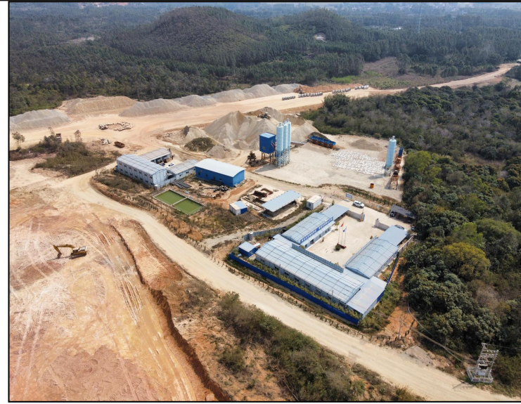
南面 广东众强建设工程有限公司
