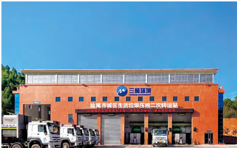
汕尾城区生活垃圾二次转运站
