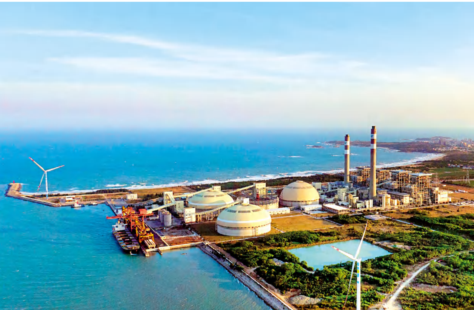
2021年11月24日，广东红海湾发电公司建成并投产了广东省首个投产的电厂侧分散式风电项目3台风力发电机组，投产后年发电量约2190万千瓦时，每年可减少二氧化碳排放约2.18万吨（广东红海湾发电有限公司/提供）
