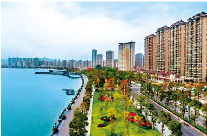
汕尾广场城市新貌一角
