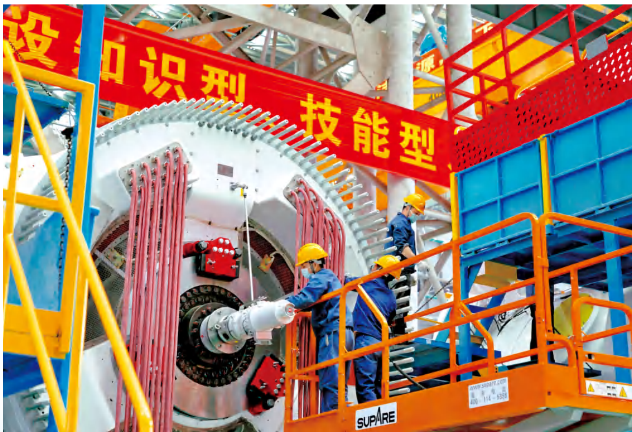
2021年，汕尾市在中国（汕尾）海上风电产业大会签约22个项目，总投资225亿元，明阳智慧能源、中天科技（一期）、天能重工等重点企业陆续投产并实现产值约90亿元，形成较完整的海上风电全产业链。图为位于陆丰市碣石的明阳能源有限公司生产车间（郑志聪/摄）
