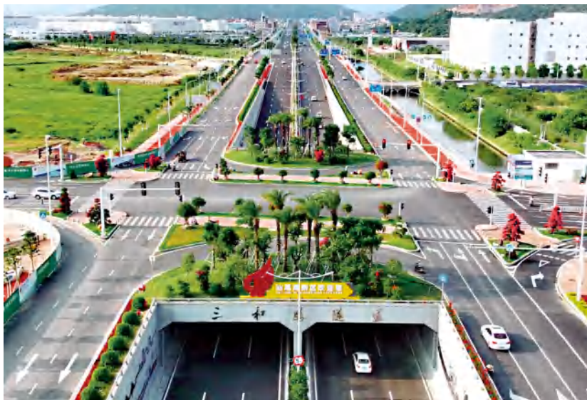
海汕路西闸至埔边段综合改造工程（市政景观绿化标）完成竣工验收 (汕尾市代建中心 提供)
