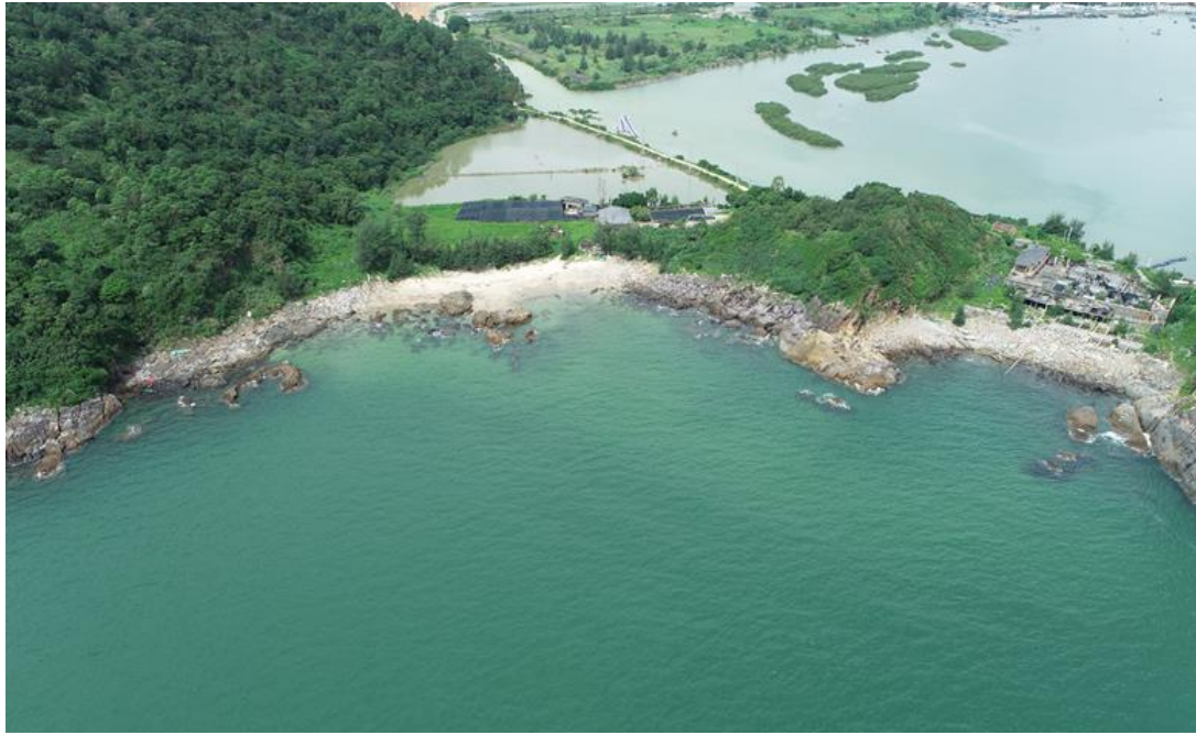
图 5.1.2-2 项目所在岸线现状
