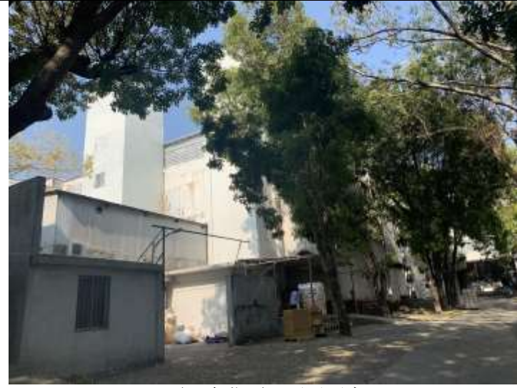
项目东北面：厂区厂房
