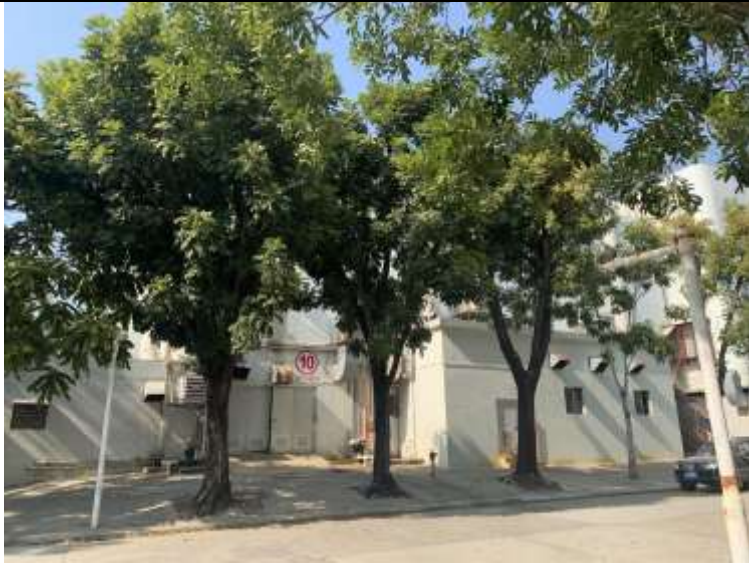
项目西北面：厂区厂房
