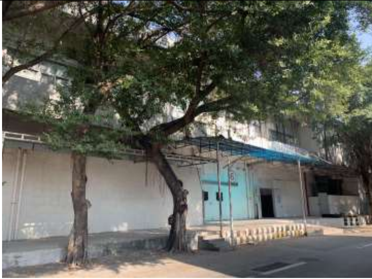
项目东南面：厂区厂房
