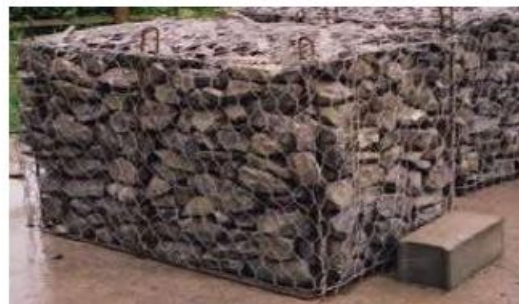
图 2.2.3-7 B 型礁体内部块石笼示意图
