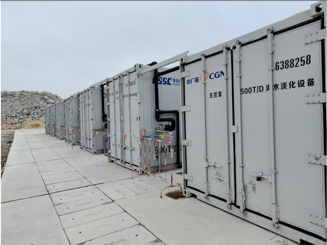
海水淡化系统（集装箱式）
