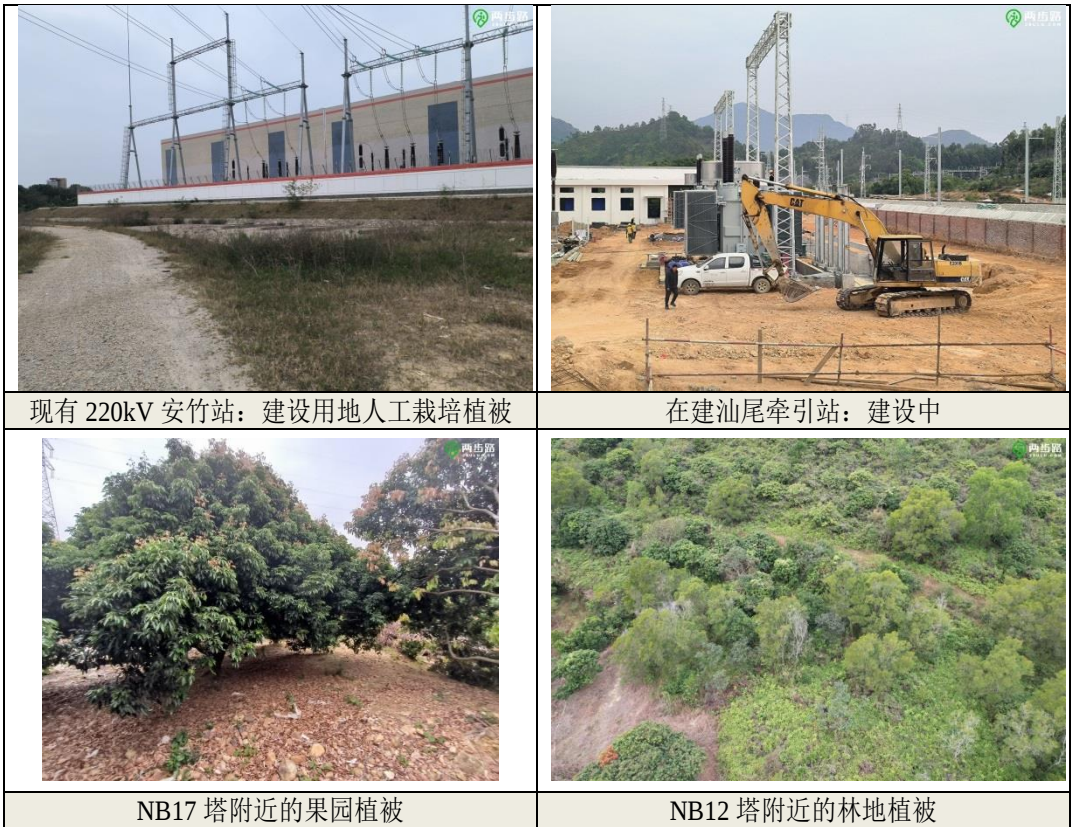
图 3.1-1 项目线路沿线生态现状照片
