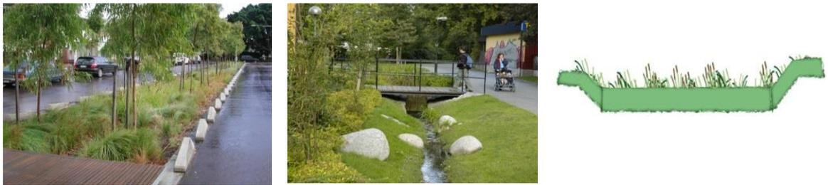
图 6-3 草沟/生态滤水带示意图
