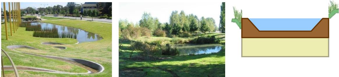
图 6-4 雨水滞留池、过滤系统示意图
