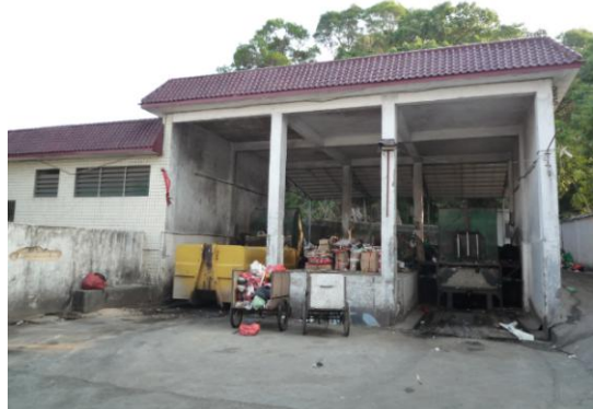
城区凤翔垃圾转运站
