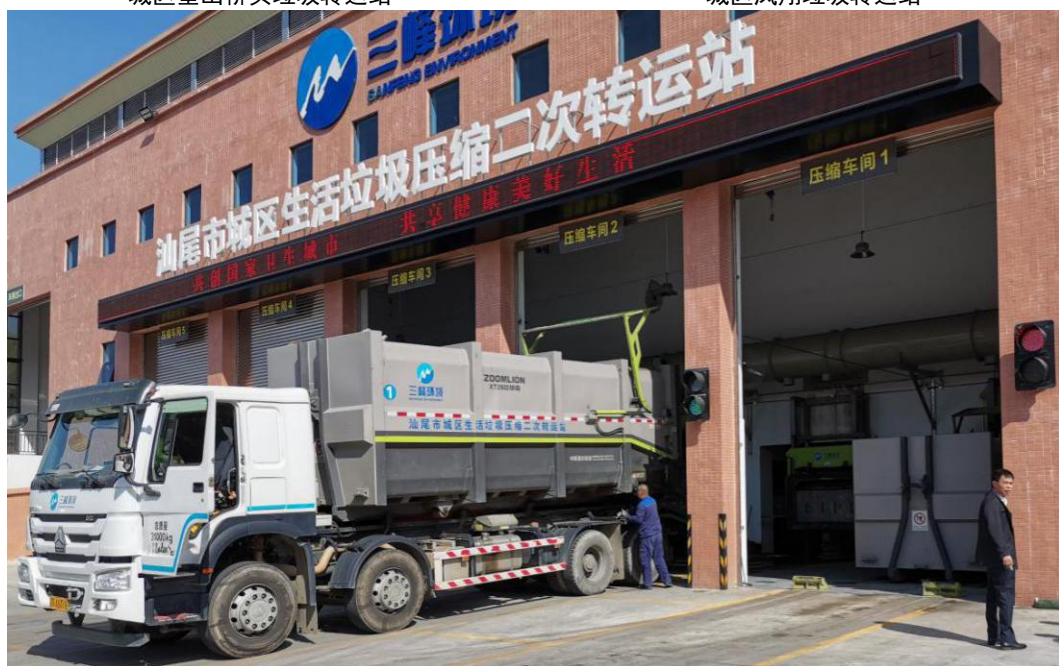
城区生活垃圾压缩二次转运站
