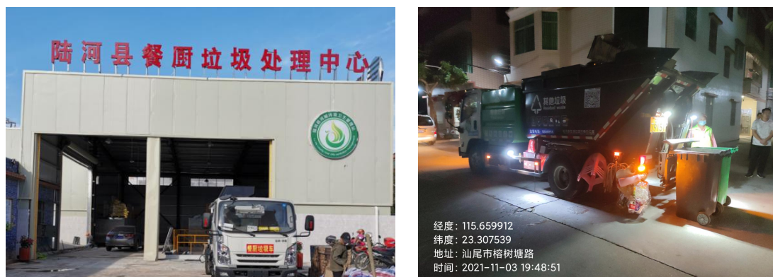
图 3-14 陆河县餐厨垃圾处理中心及垃圾分类转运车辆
