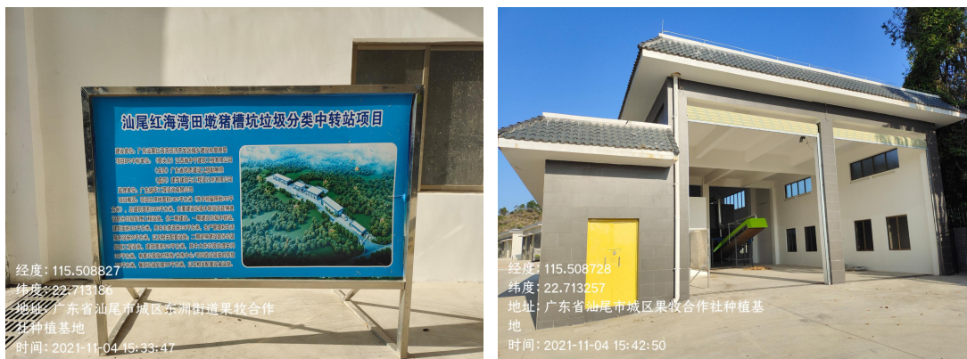
图 3-16 田墘猪槽坑垃圾分类中转站
