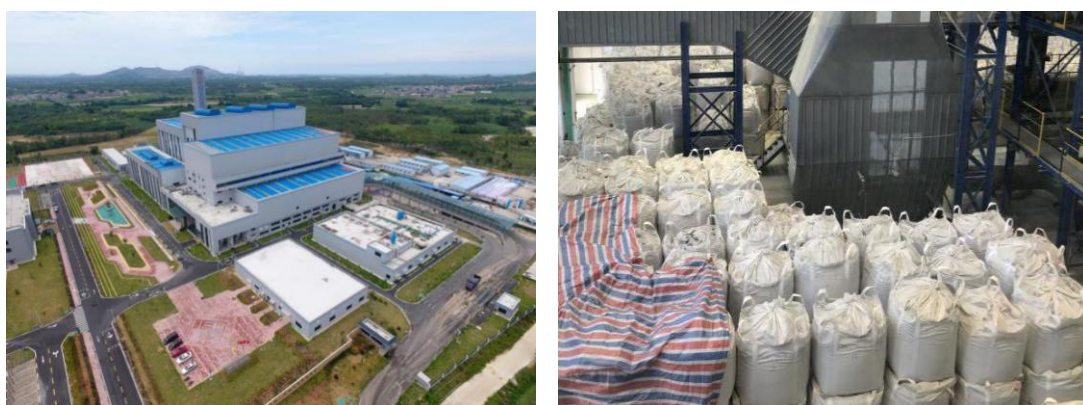
图 3-6 陆丰东南焚烧厂一期（运营中）
