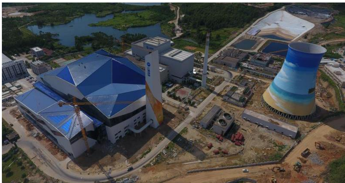
图 3-4 汕尾市生活垃圾无害化处理中心二期（航拍）
