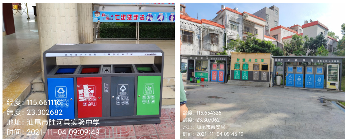
图 3-13 陆河县生活垃圾分类投放设施
