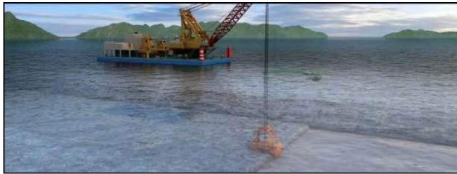
图 2-5 (c) 抓斗船施工示意图
