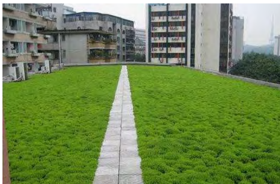
图 3-2 佛甲草简易型屋顶成坪效果
