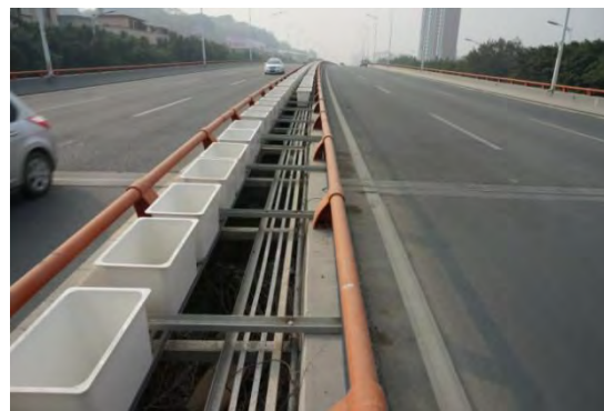
图 1-2 天桥、立交桥种植槽悬挂固定
