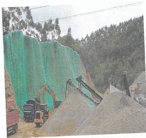
照片 4.3-2 边坡防护
