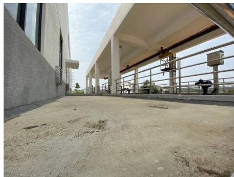
赤沙水厂取水口
