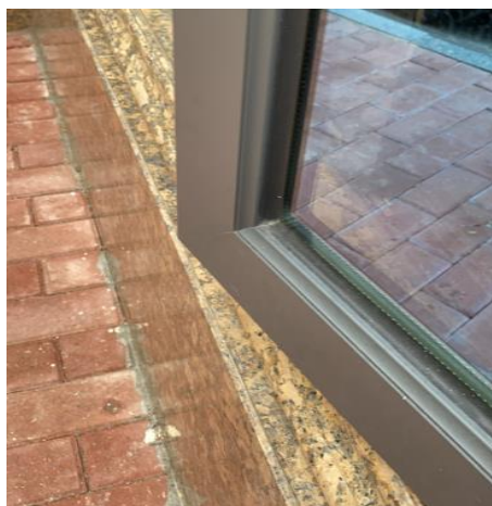
图 7.3-1 瑞城花园已安装双层窗实景图
