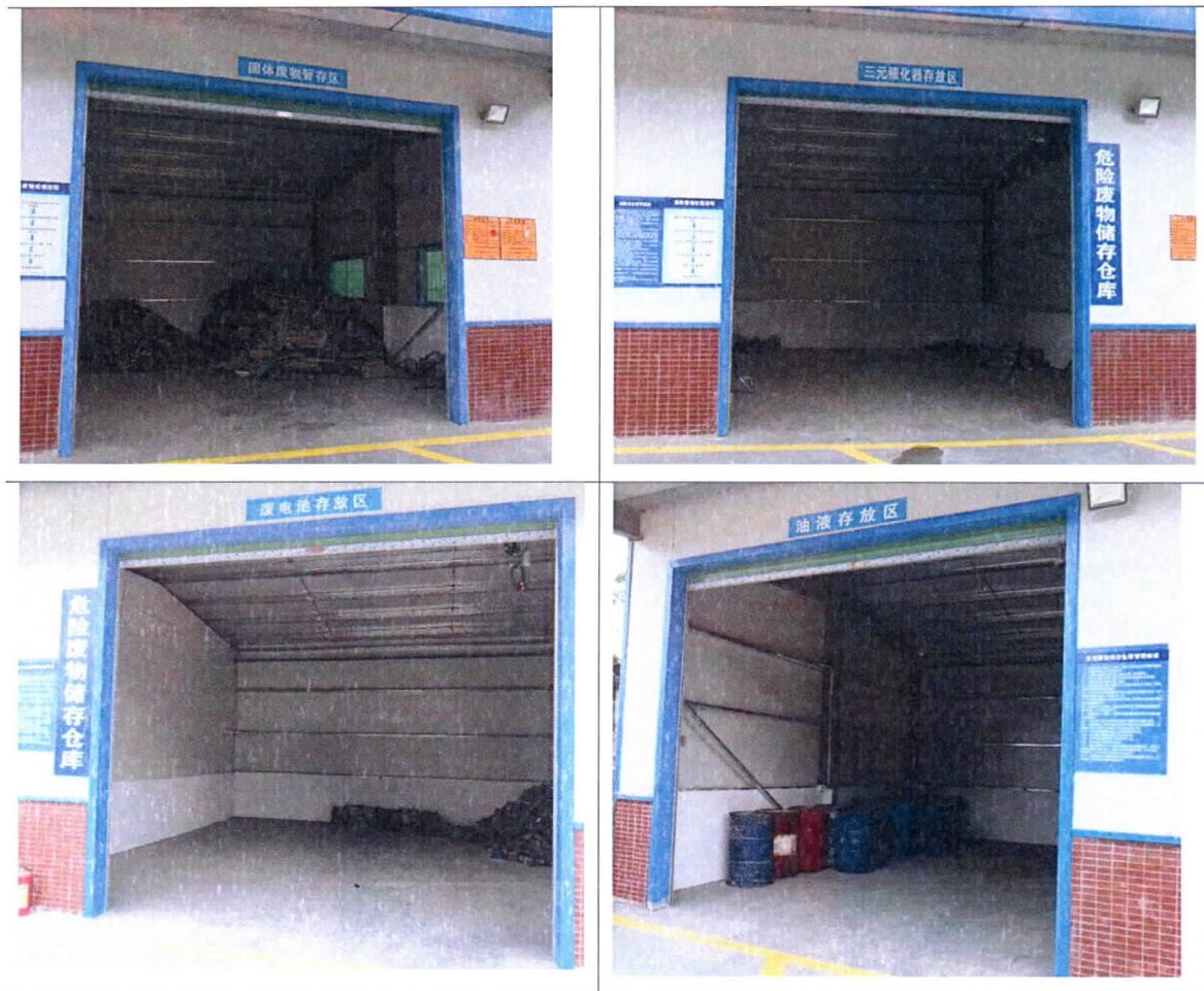
图 4.1-2 固废暂存区图片
